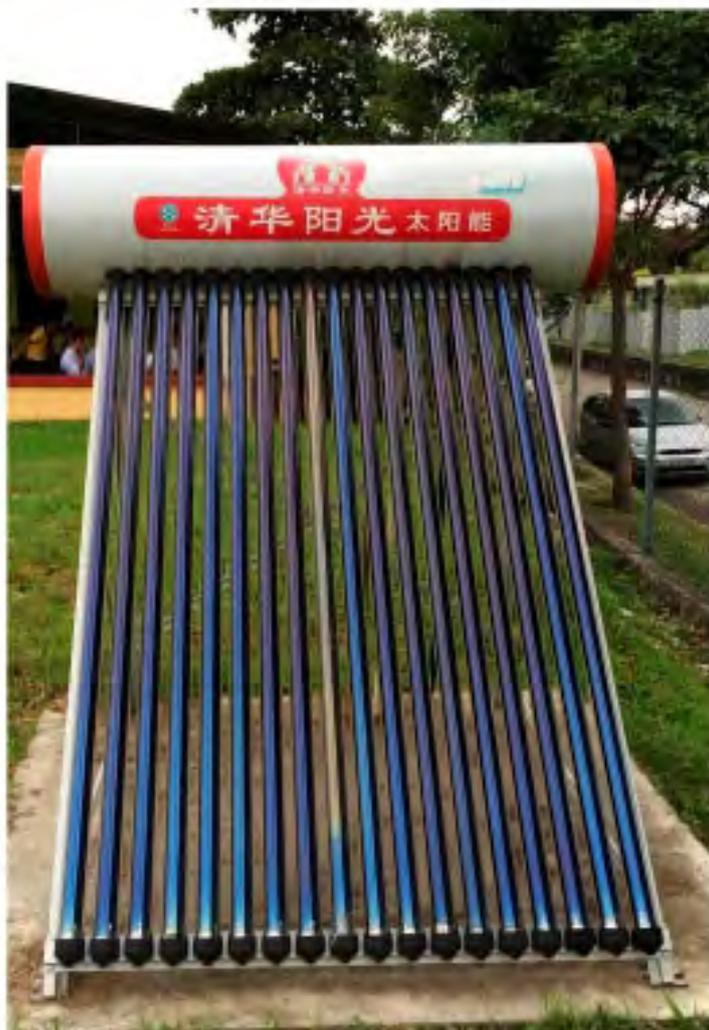
Figura 20. Sistema de aquecimento solar térmico instalado no Grêmio.
