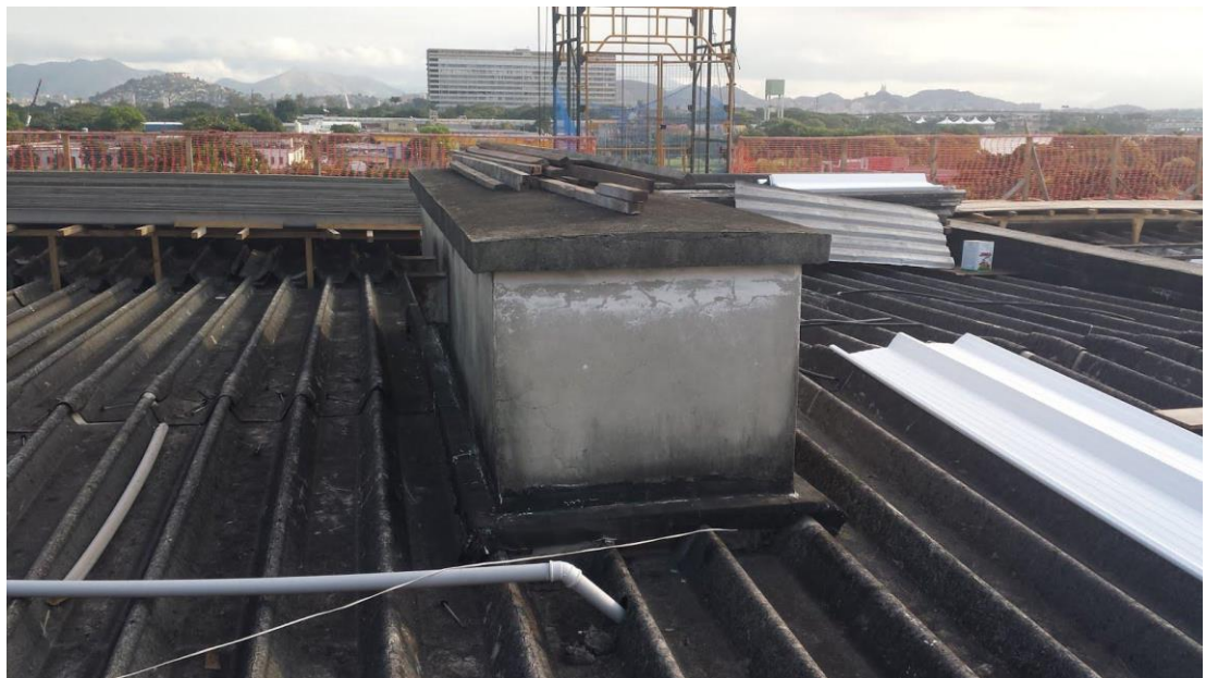
Figura 16. Telhado do alojamento de estudantes onde serão instalados os coletores solares.
