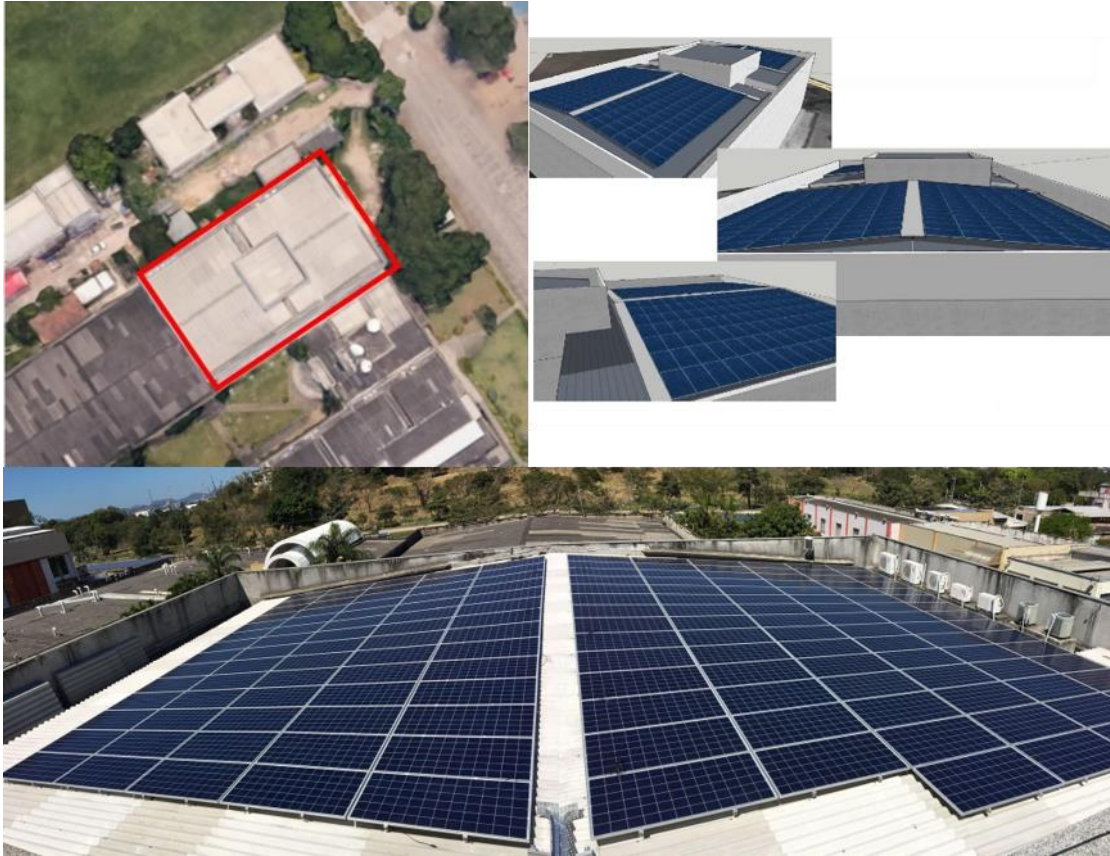
Figura 15: Sistema Fotovoltaico na cobertura do Bloco M do CT.
